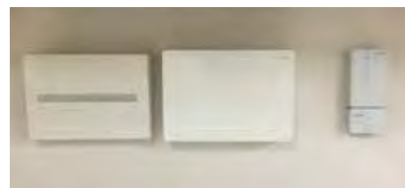
スマートAIは分電盤に隣接して設置します
