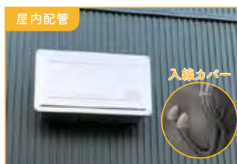
屋内配管 パワーコンディショナーへの配管・配線が壁内を通ります。
