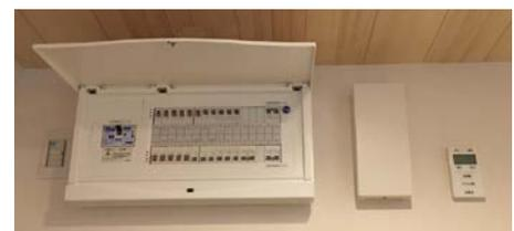
非常用コンセント、送信ユニット、リモコンは分電盤に隣接して設置します
