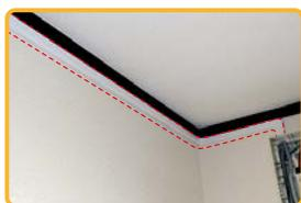
パワーコンディショナーの設置面の上部の壁から入線をします
