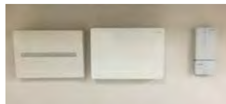
スマートAIは分電盤に隣接して設置します
