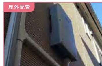
パワーコンディショナーへの配管・配線が外壁材の外側を通ります。
