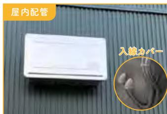
パワーコンディショナーへの配管・配線が壁内を通ります。
