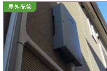
屋外配管 パワーコンディショナーへの配管・配線が外壁材の外側を通ります。
