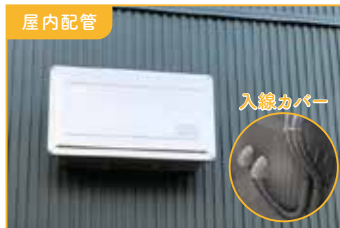
屋内配管 パワーコンディショナーへの配管・配線が壁内を通ります。
