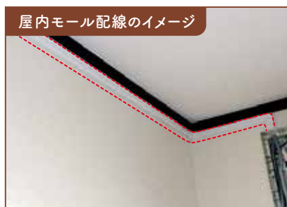
屋内モール配線のイメージ 屋内側の配線が内壁材の外側を 通る場合があります。(赤点線部)
