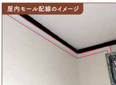
屋内モール配線のイメージ 屋内側の配線が内壁材の外側を 通る場合があります。(赤点線部)
