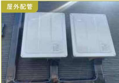
パワーコンディショナへの配管・配線が 外壁材の外側を通ります。
