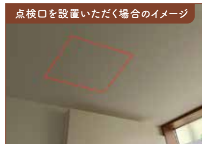
点検口を設置いただく場合のイメージ 屋内の配線をする場合に、点検口をビルダー様に複数箇所設置いただく必要が発生する場合があります。
