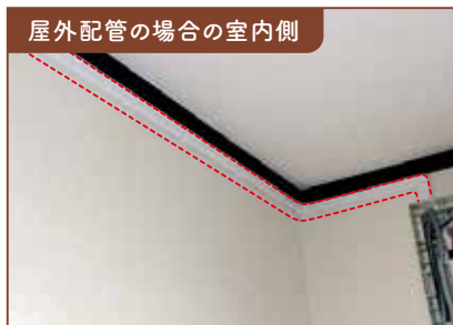
屋外配管の場合の室内側 屋内側の配線が内壁材の外側を通る場合があります。(赤点検口)
