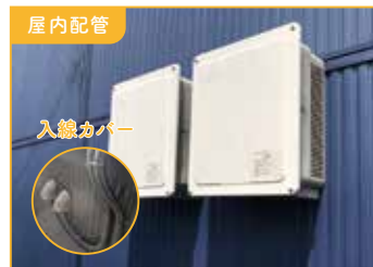
屋内配管 パワーコンディショナへの配管・配線が 壁内を通ります。
