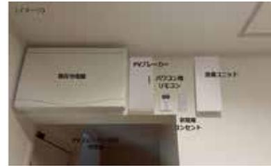
非常用コンセント、送信ユニット、リモコンは分電盤に隣接して設置します
