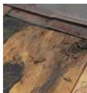
野地板の取り替え、屋根材の葺き直しが条件となります
