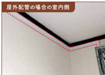
屋内側の配線が内壁材の外側を通る場合があります。(赤点検口)
