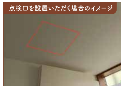
屋内の配線をする場合に、点検口をビルダー様に複数箇所設置いただく必要が発生する場合があります。
