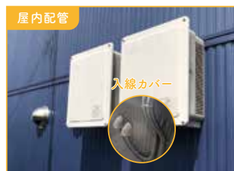
屋内配管 パワーコンディショナへの配管・配線が壁内を通ります。
