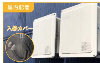
屋内配管 パワーコンディショナーへの配管・配線が壁内を通ります。
