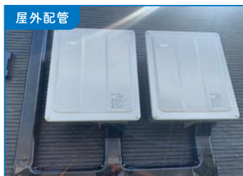
屋外配管 パワーコンディショナーへの配管・配線が外壁材の外側を通ります。
