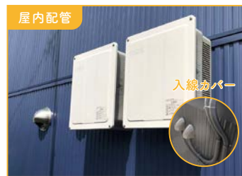
屋内配管 パワーコンディショナーへの配管・配線が壁内を通ります。
