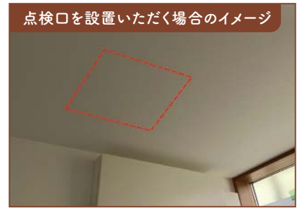
点検口を設置いただく場合のイメージ 屋内の配線をする場合に、点検口をビルダー様にて 複数箇所設置いただく必要が発生する場合があります。
